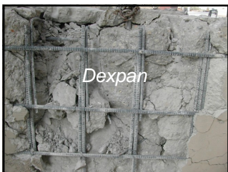
Aquí se muestra la varilla de acero # 6 dentro de la base de concreto.
