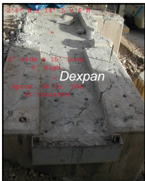
Base de 7' 3" largo X 4' 7" ancho X 10" alto con tres niveles, barrilla # 6. En esta demolición se utilizaron solamente 1 caja ½ de Dexpan.
