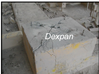
Base de motor de cemento reforzado, se demolió fácilmente con pocos barrenos y Dexpan.
