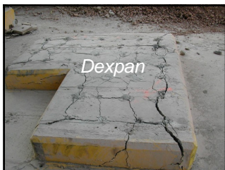
Base de 7' 3" largo X 4' 7" ancho X 10" alto con tres niveles, barrilla # 6. En esta demolición se utilizaron solamente 1 caja ½ de Dexpan.
